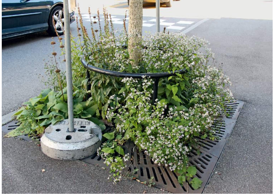
// Begrünte Metallroste heizen sich weniger stark auf, die verwendeten Arten sind sehr regenerationsfähig. //
